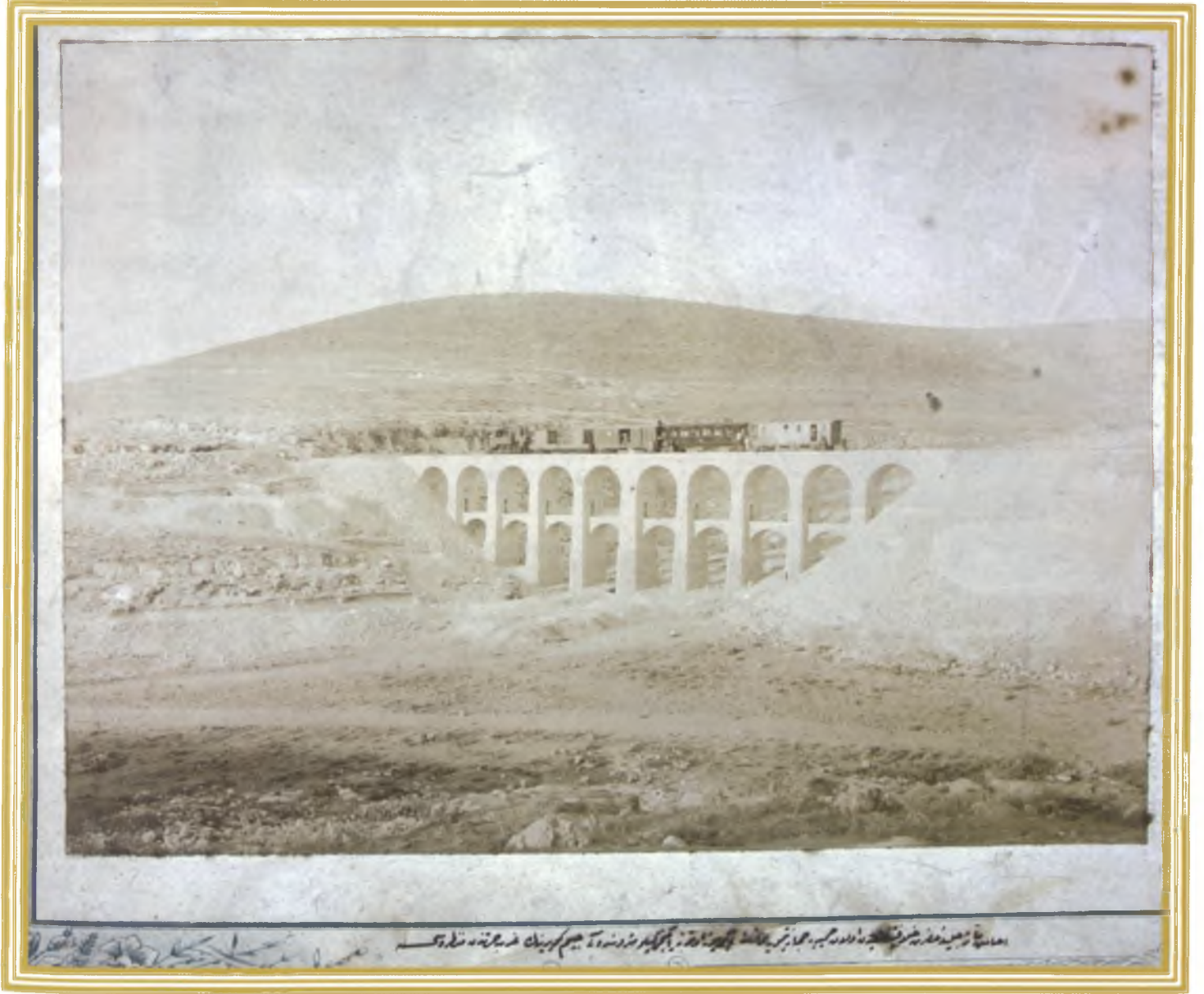
Ehâsin meâsir-i celîle-i Hazret-i hilâfetpenâhî'den olan Hamidiyye Hicaz Demiryolu'nun iki yüz otuz ikinci kilometresindeki cesim köprü'nün garb cihetinden manzarası. Hamidiyye Hicaz Demiryolu'nun iki yüz otuz ikinci kilometresindeki büyük köprü'nün batı tarafından görünümü. 21x 28.5 cm, Env. No. 100 / 454.
